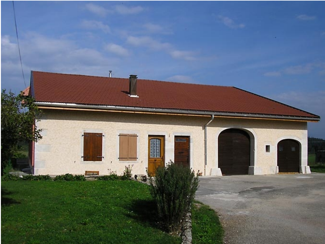
Vue latérale de la façade antérieure.
