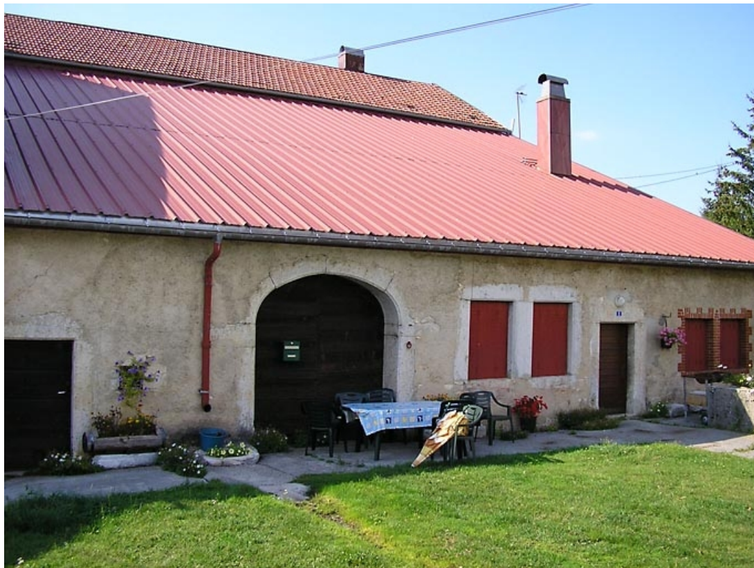
Vue de la façade antérieure.
