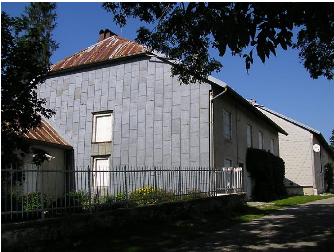
Pignon sud-ouest vu de trois quarts.
