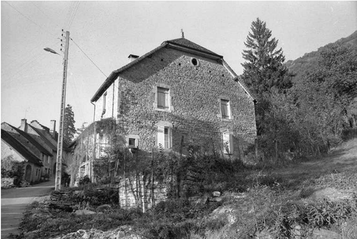
Maison cadastrée 1965 AD 105 : façade est. 39, Nevy-sur-Seille
