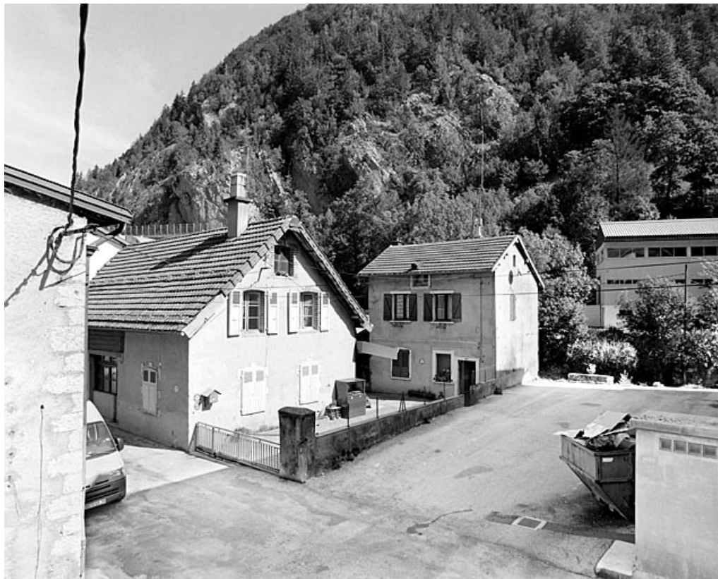
Vue d'ensemble, depuis le sud-ouest : élévations antérieures.
