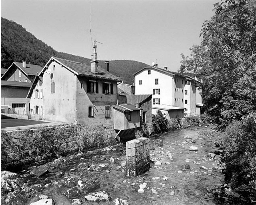
Vue d'ensemble, depuis le sud-est : élévations postérieures.
