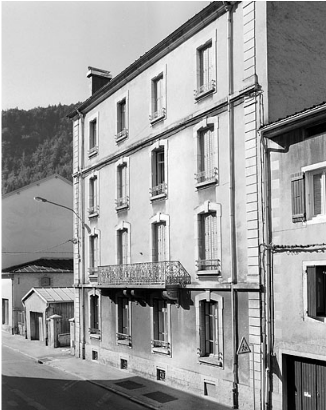
Vue d'ensemble depuis le nord-est : élévation antérieure.
