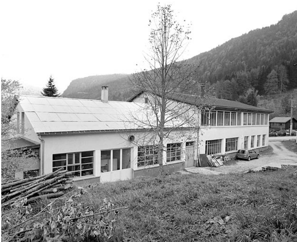
Vue d'ensemble depuis le nord : élévation postérieure.
