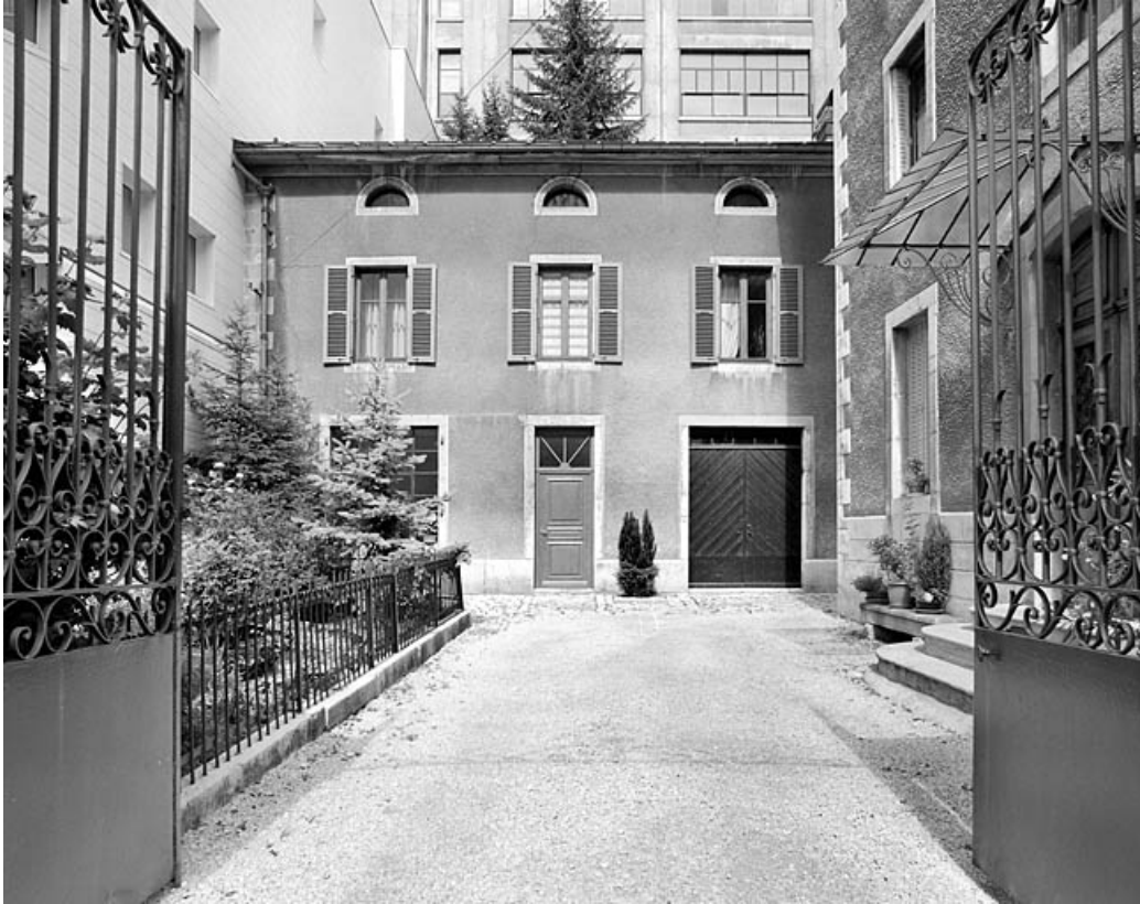
Façade antérieure de l'atelier.
