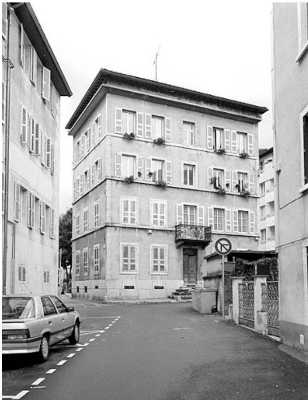
Elévation antérieure, de trois quarts gauche.
