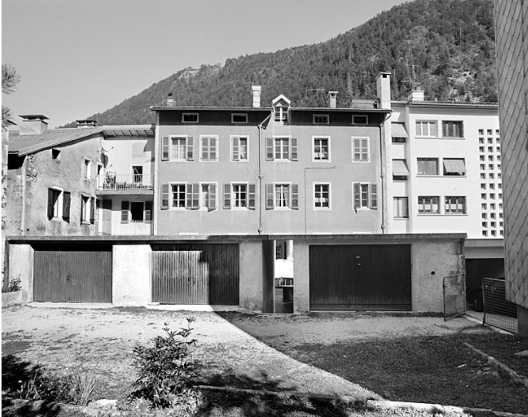
Elévation postérieure et garages.
