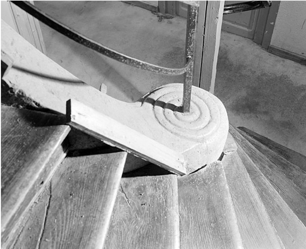
Escalier tournant : départ de la rampe d'appui.
