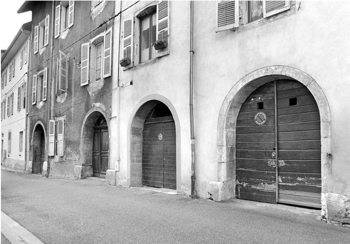
Maison au n° 30 : baies du rez-de-chaussée.
