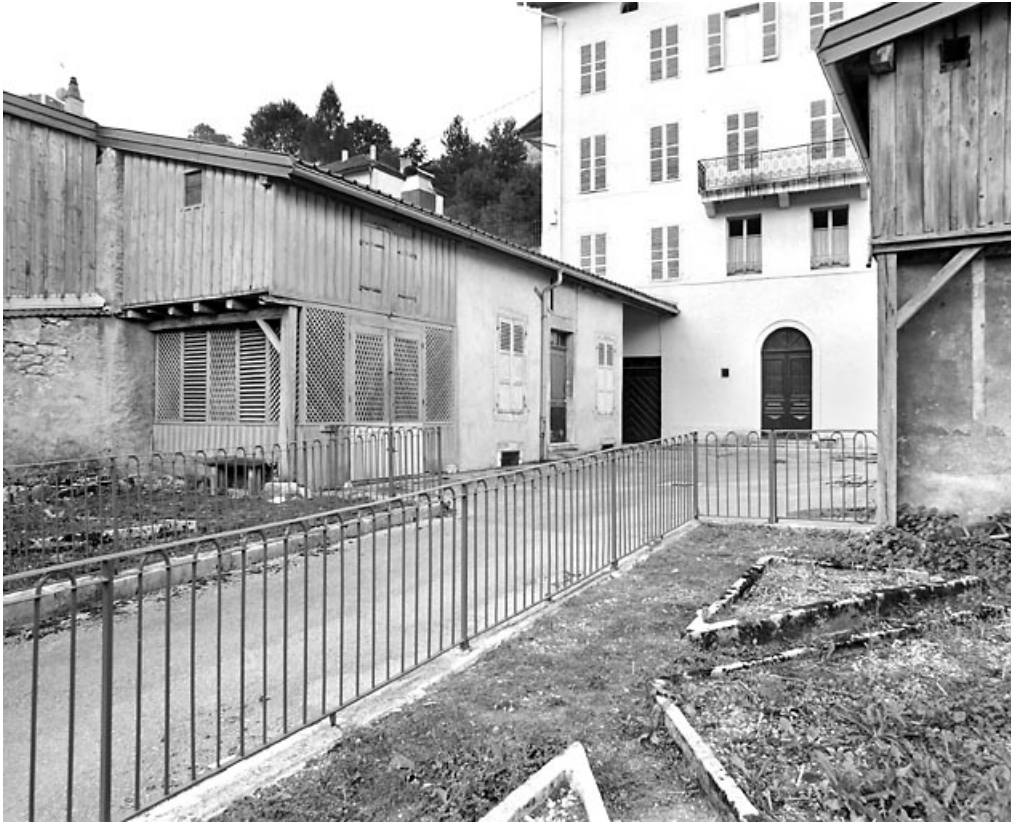
Jardin, cour et bâtiment sud.
