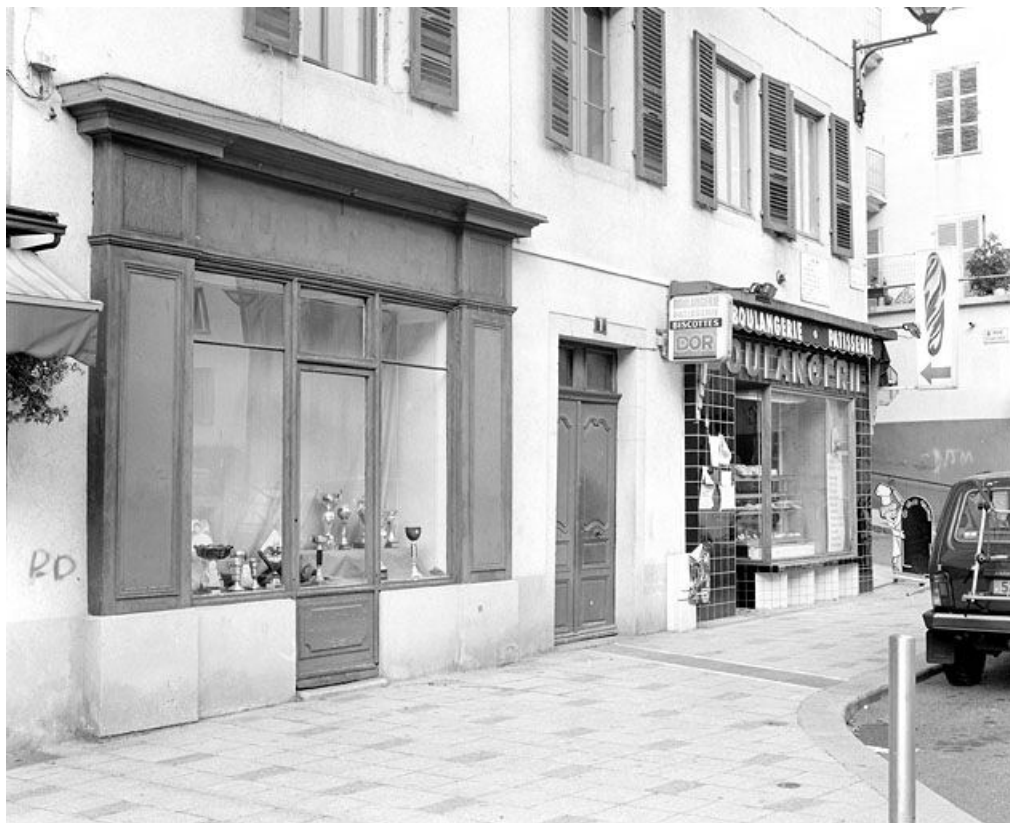
Rez-de-chaussée de l'élévation antérieure.
