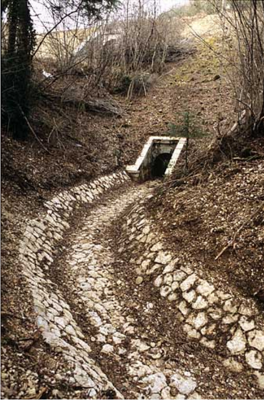
Aqueduc : tête aval (ouest) et rigole.
