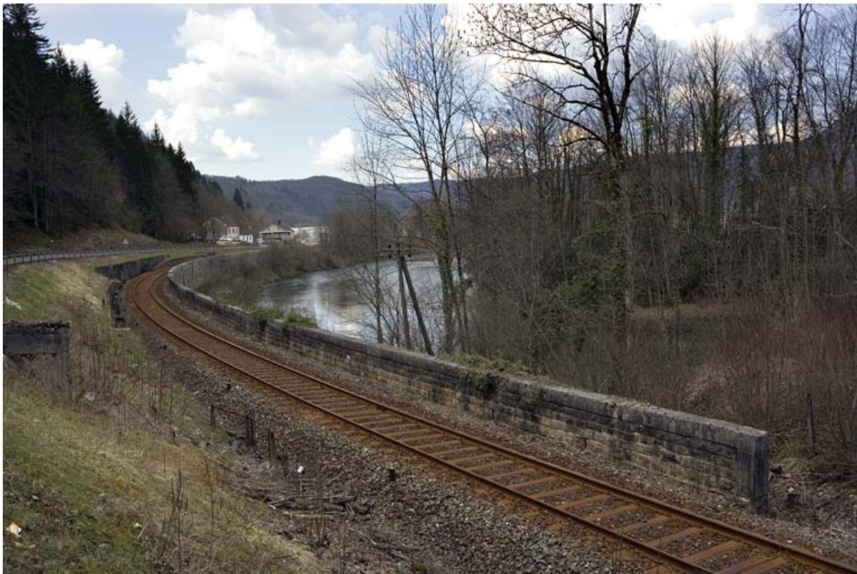
Vue d'ensemble, depuis le côté Andelot-en-Montagne.
