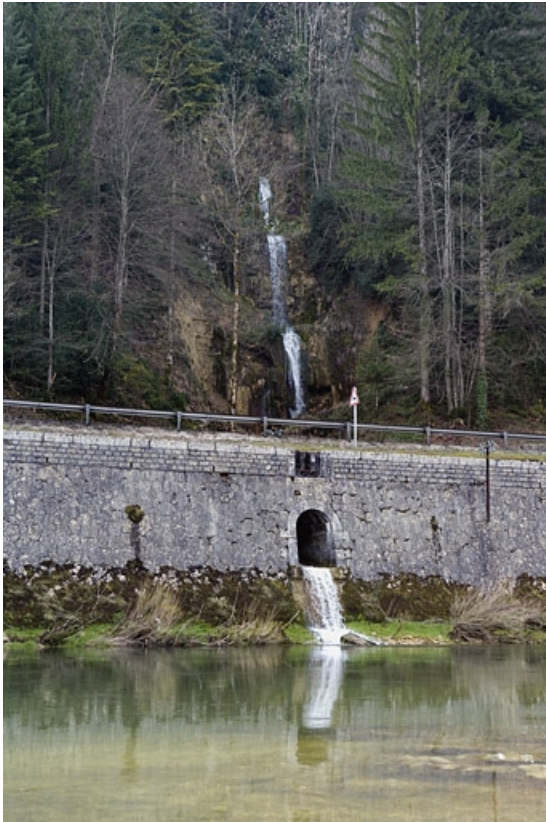
Aqueduc du ruisseau du Tournachut.
