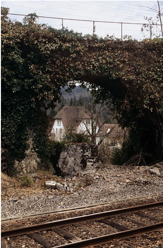
Pont du tacot : arche en plein-cintre.
