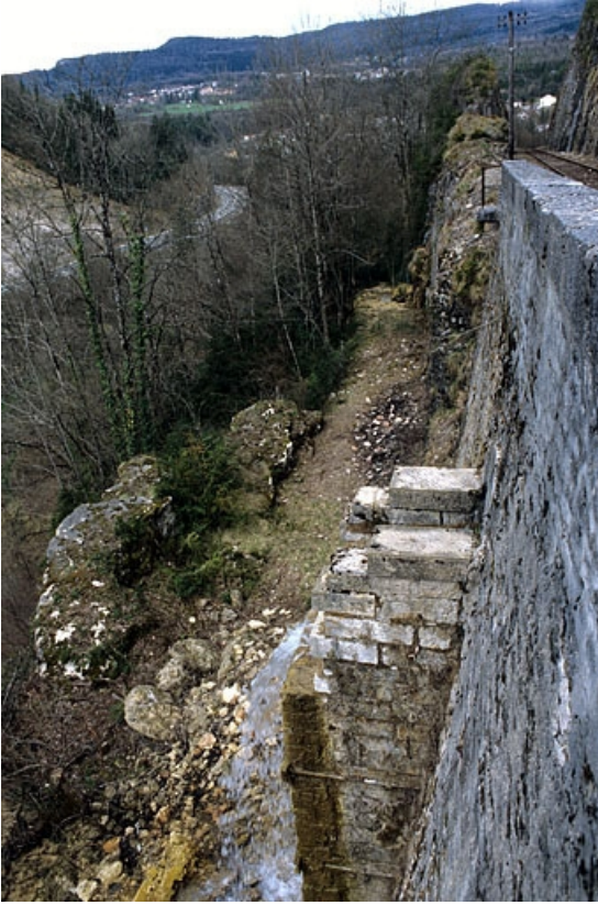
Débouché du premier aqueduc.
