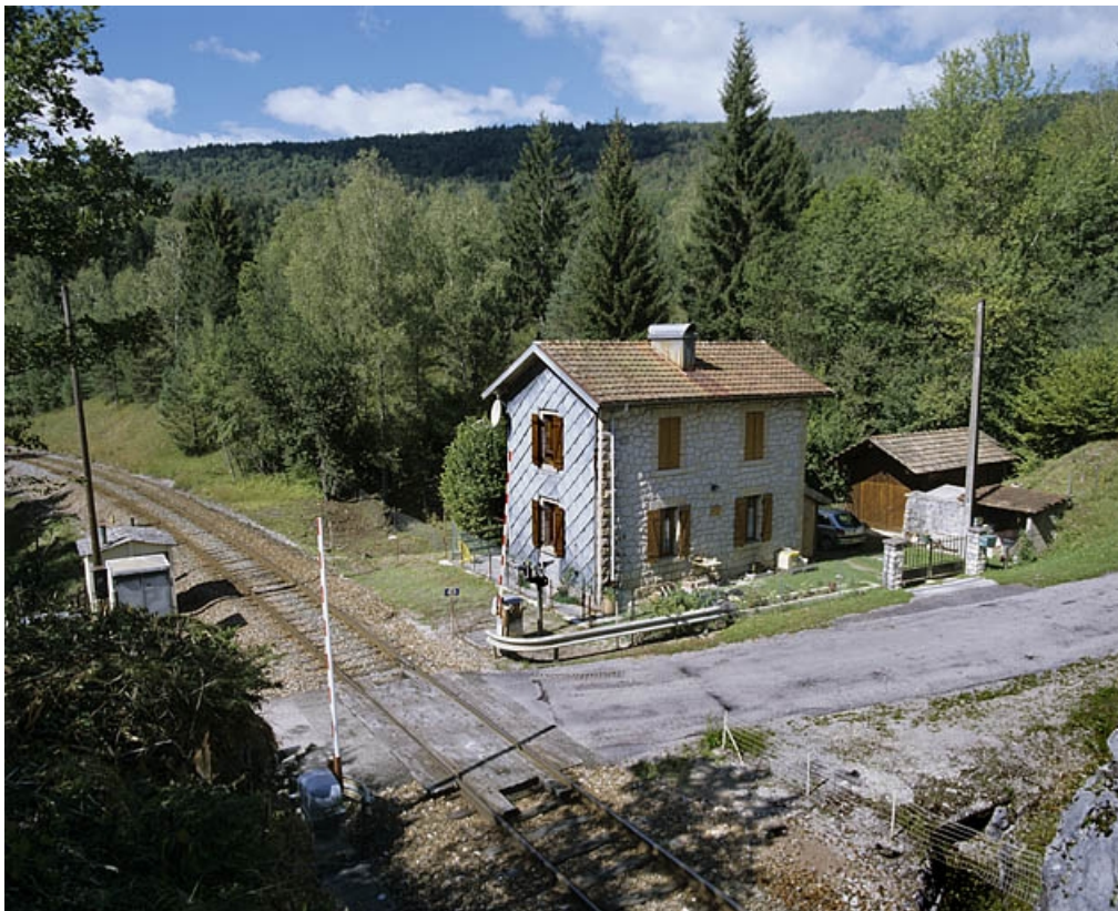
Vue d'ensemble plongeante, depuis le sud-est.
