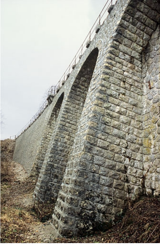
Talus du mur au niveau des arcades.
