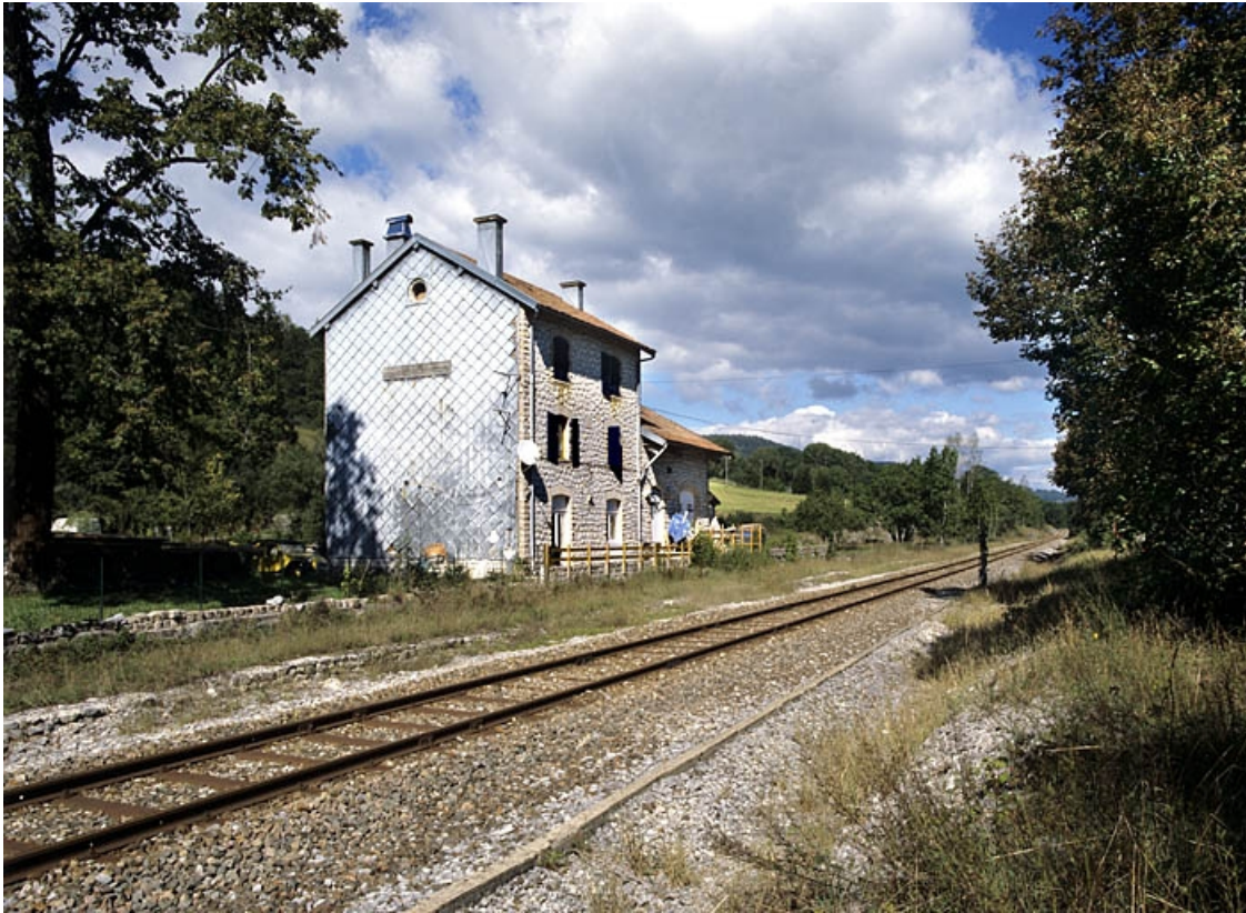
Vue d'ensemble, depuis le sud (façade postérieure).
