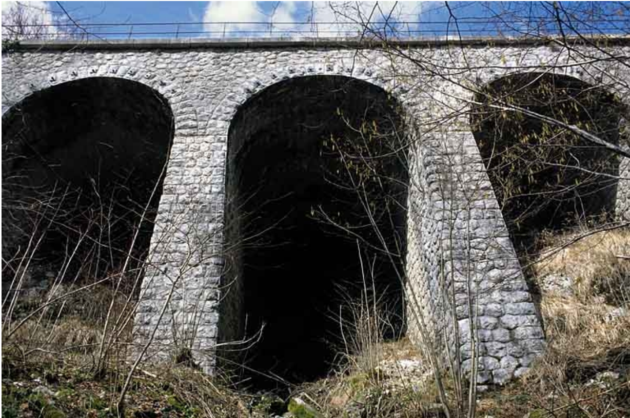
Mur de soutènement de la route : arcades.
