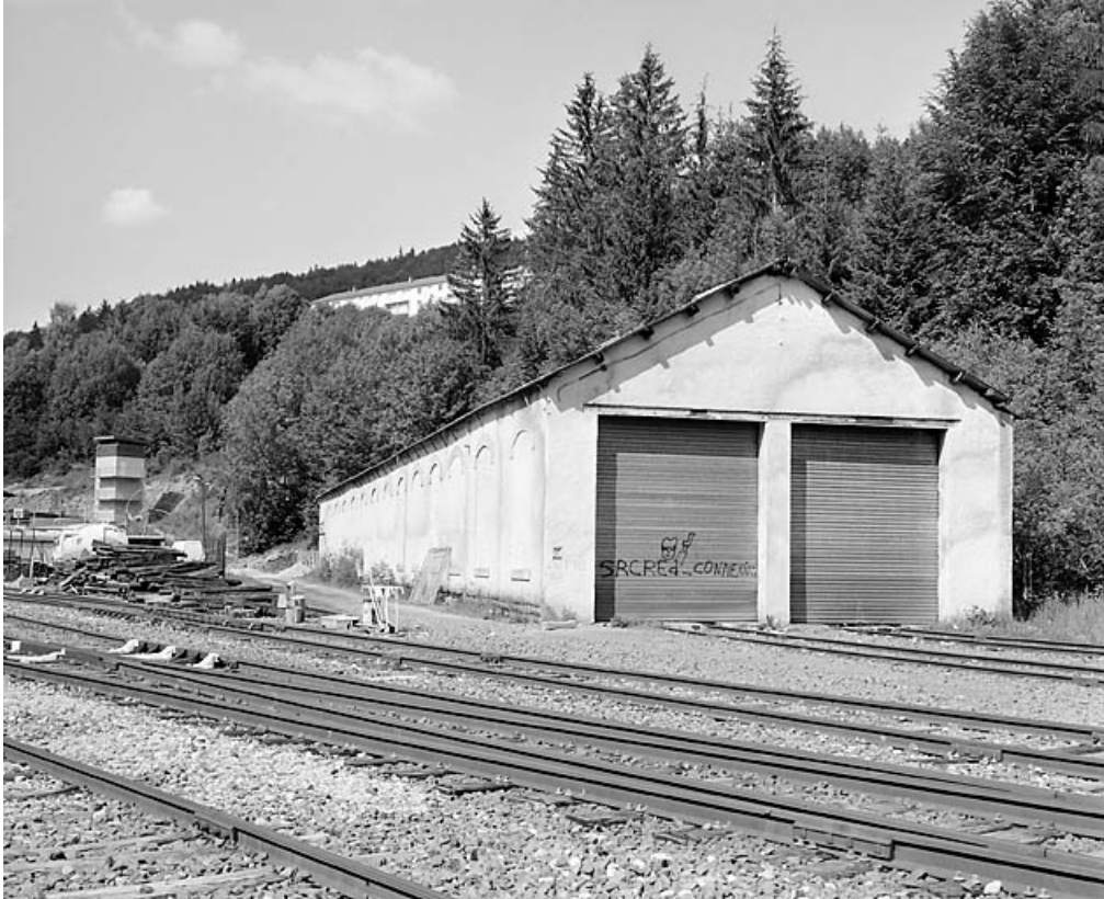
Remise ferroviaire, depuis le sud.
