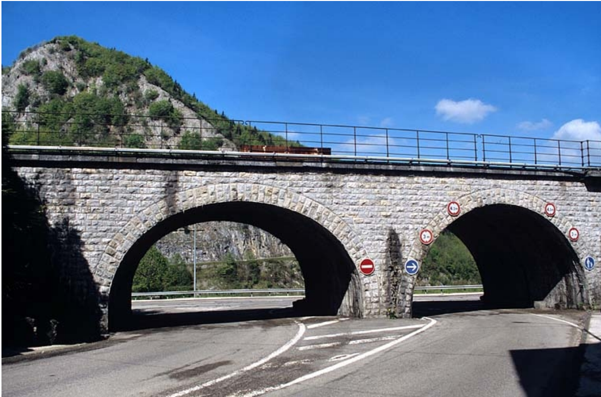
Elévation occidentale : arches enjambant la rue.
