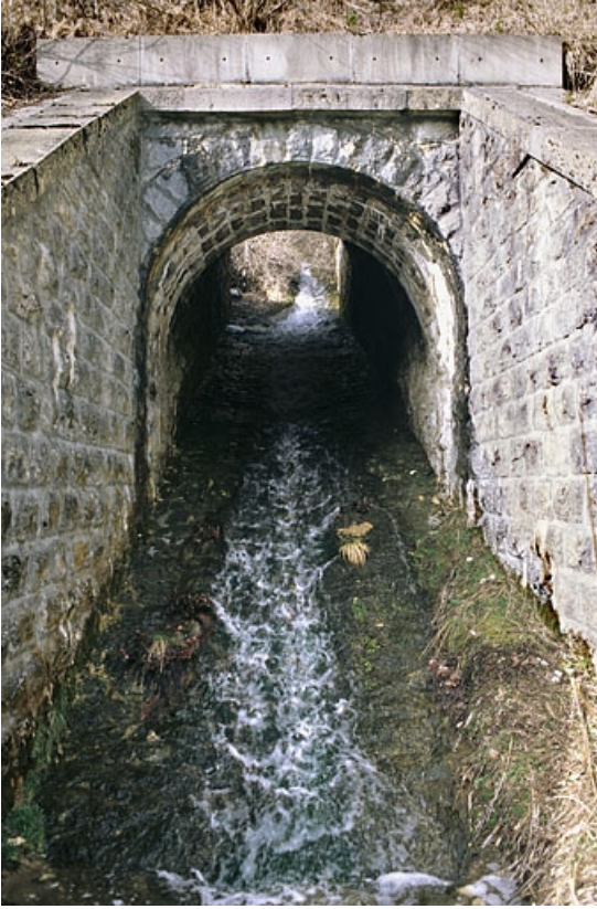
Pont : vue d'ensemble, depuis le sud (aval).
