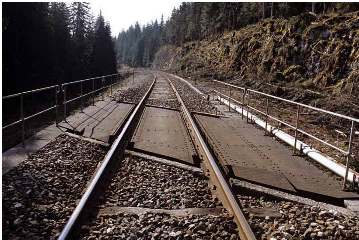
Tablier métallique, depuis la voie côté Andelot-en-Montagne.
