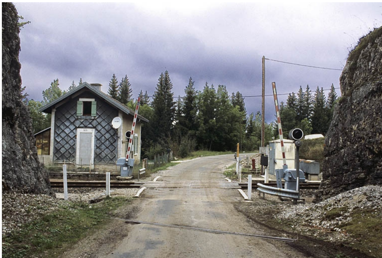
Façade sud (côté voie).
