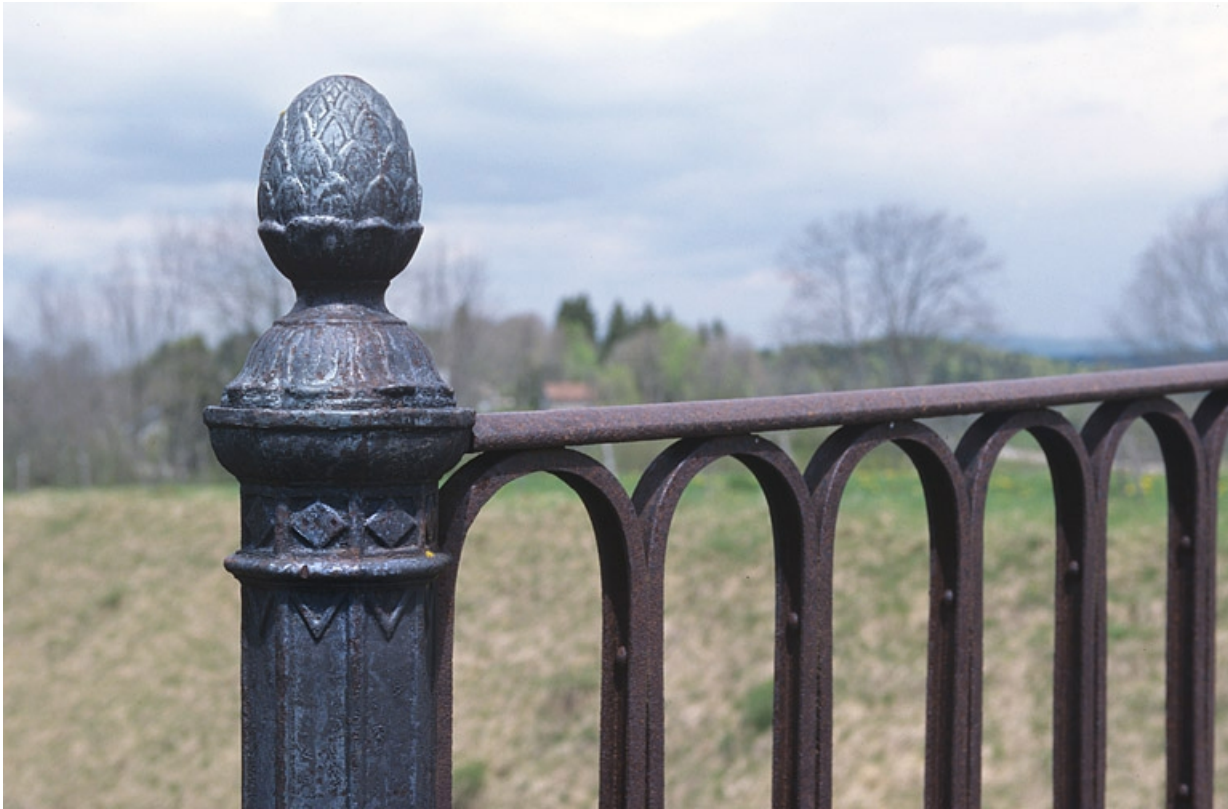
Motif d'amortissement d'un potelet du garde-corps.
