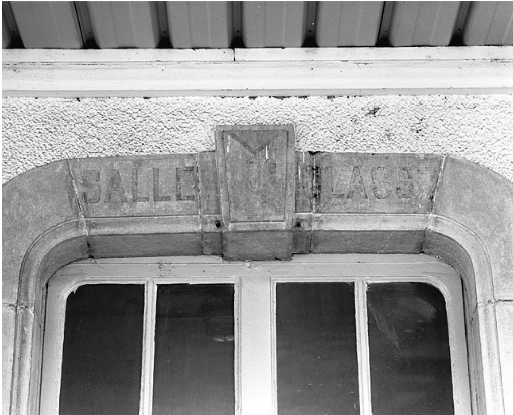
Bâtiment des voyageurs : plate-bande d'une fenêtre de la salle d'attente de troisième classe. 39, Champagnole, 13 avenue de la Gare
