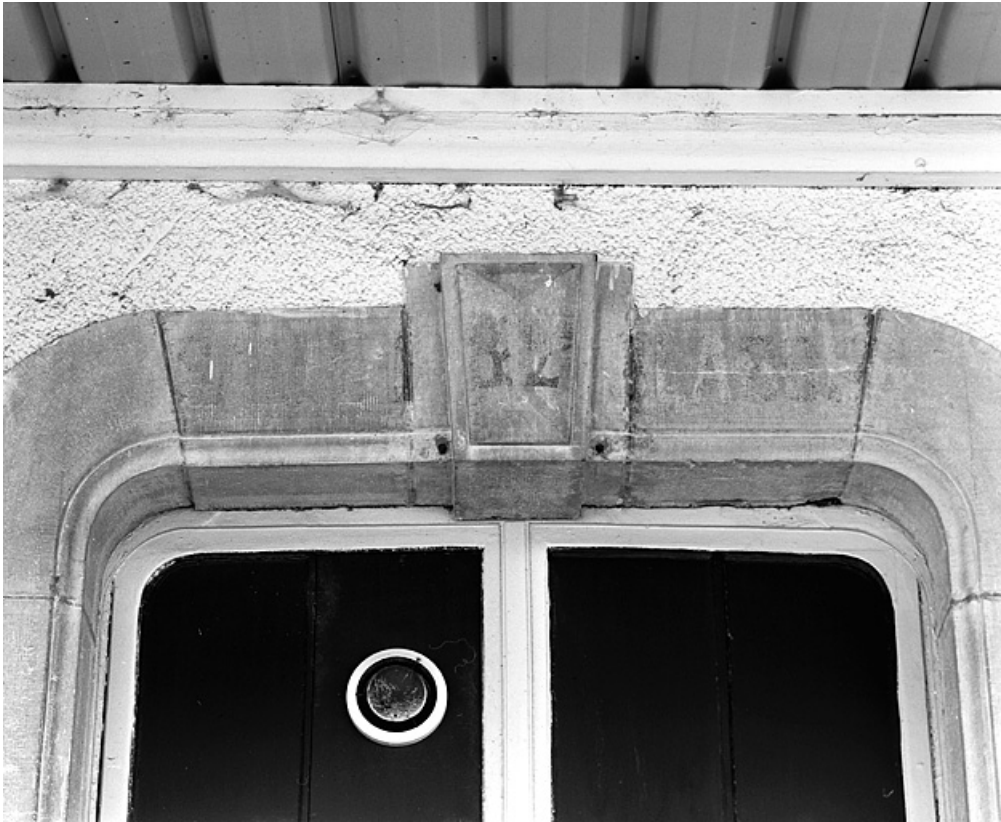
Bâtiment des voyageurs : plate-bande d'une fenêtre.
