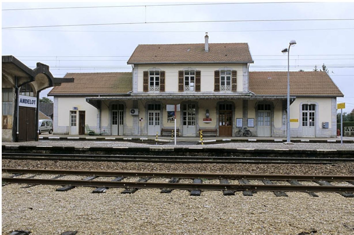
Bâtiment des voyageurs : façade postérieure, de face.
