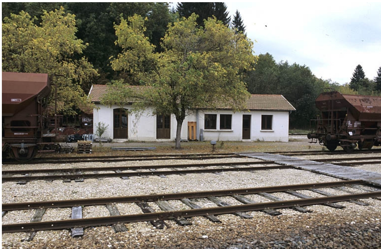
Ancienne lampisterie (bureau des électriciens), de face.
