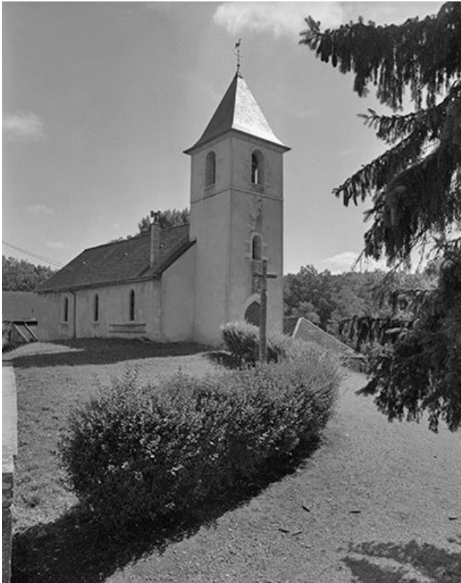
Façades antérieure et latérale gauche.
