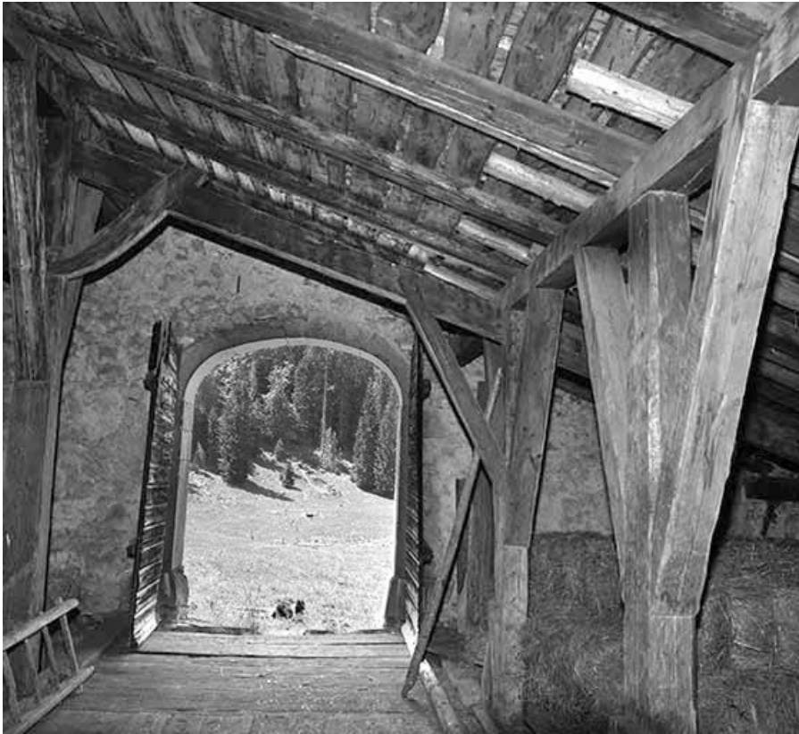
Vue intérieure de la charpente.
