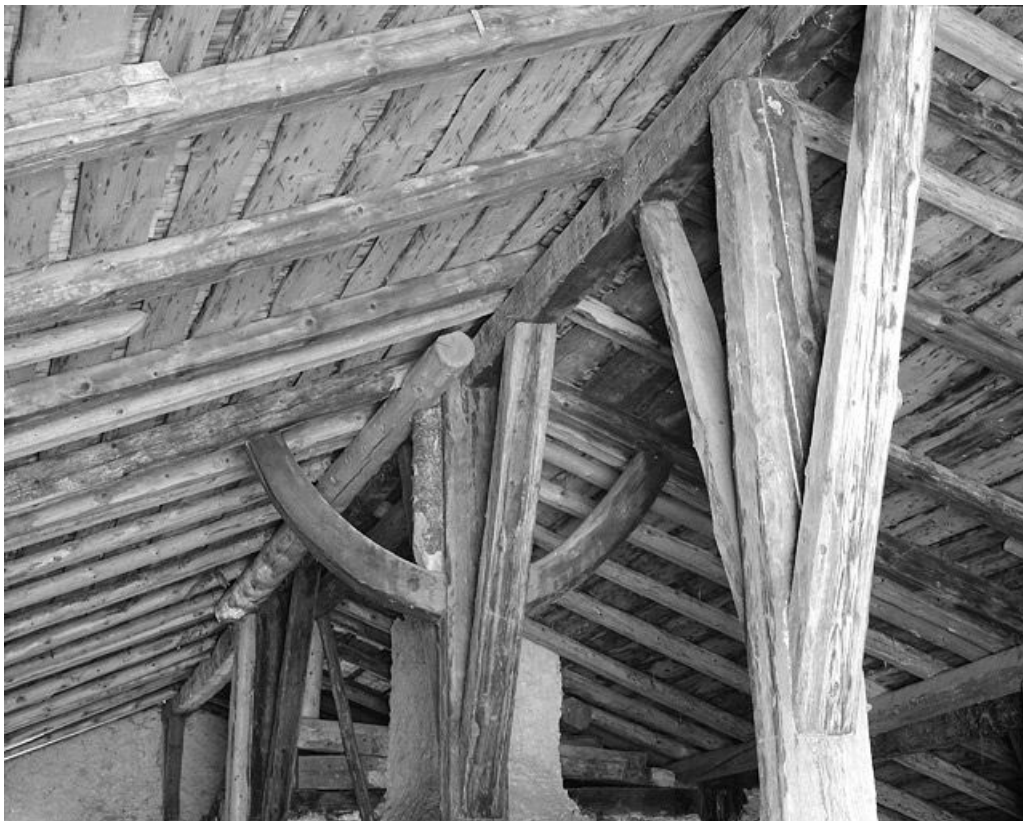
Charpente, colonne sous faitage et contrefiche.
