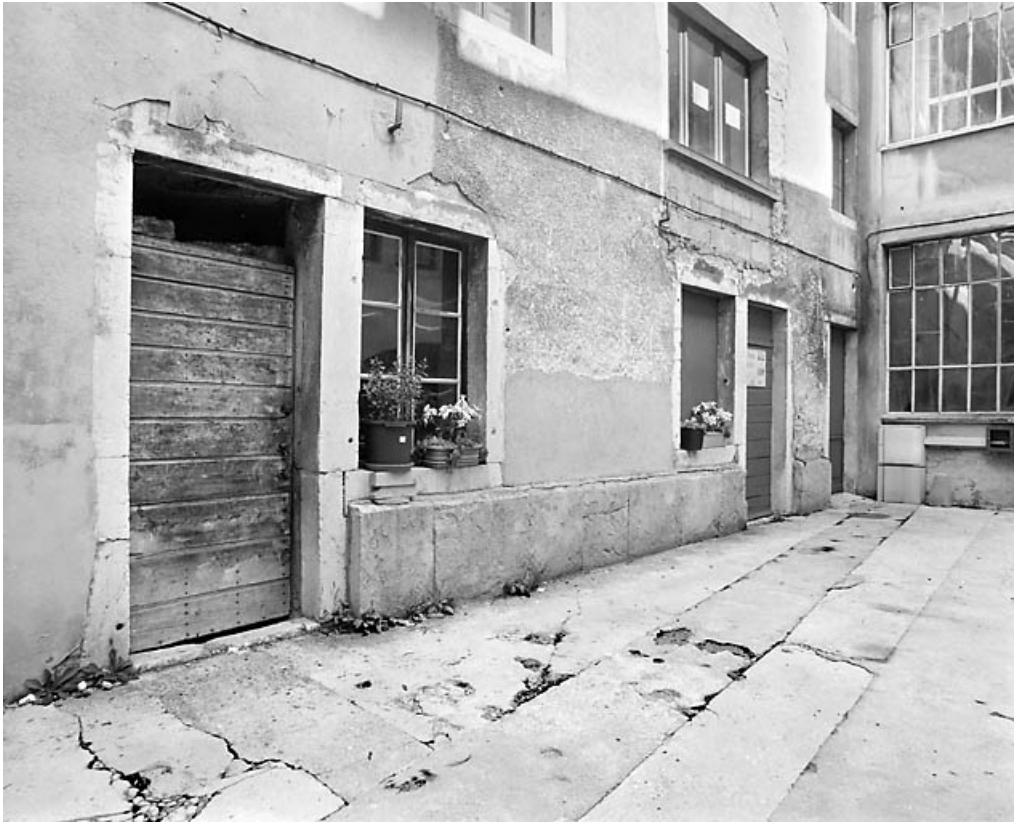
Aile nord : rez-de-chaussée, de trois quarts gauche.
