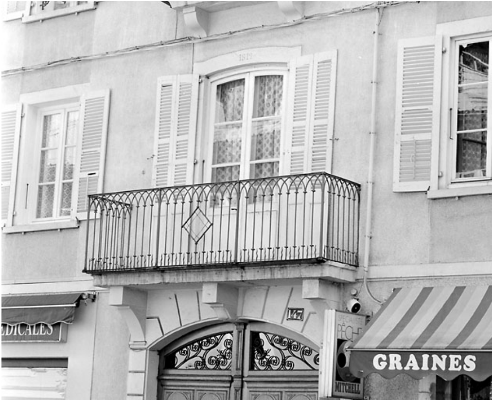
Porte-fenêtre et balcon du premier étage.
