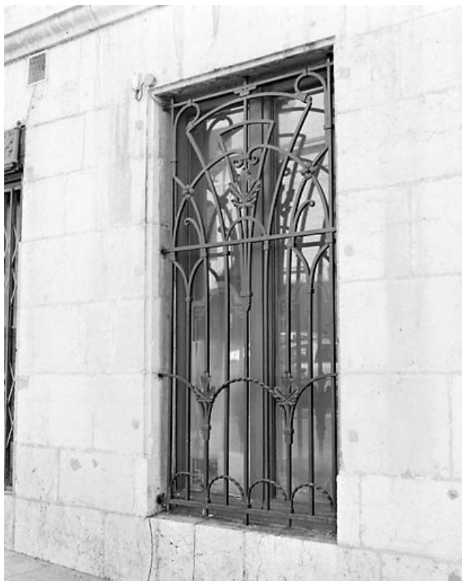
Façade latérale gauche : grille Art déco.
