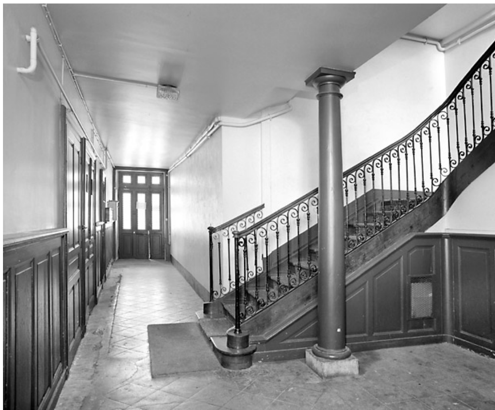
Couloir et escalier tournant.
