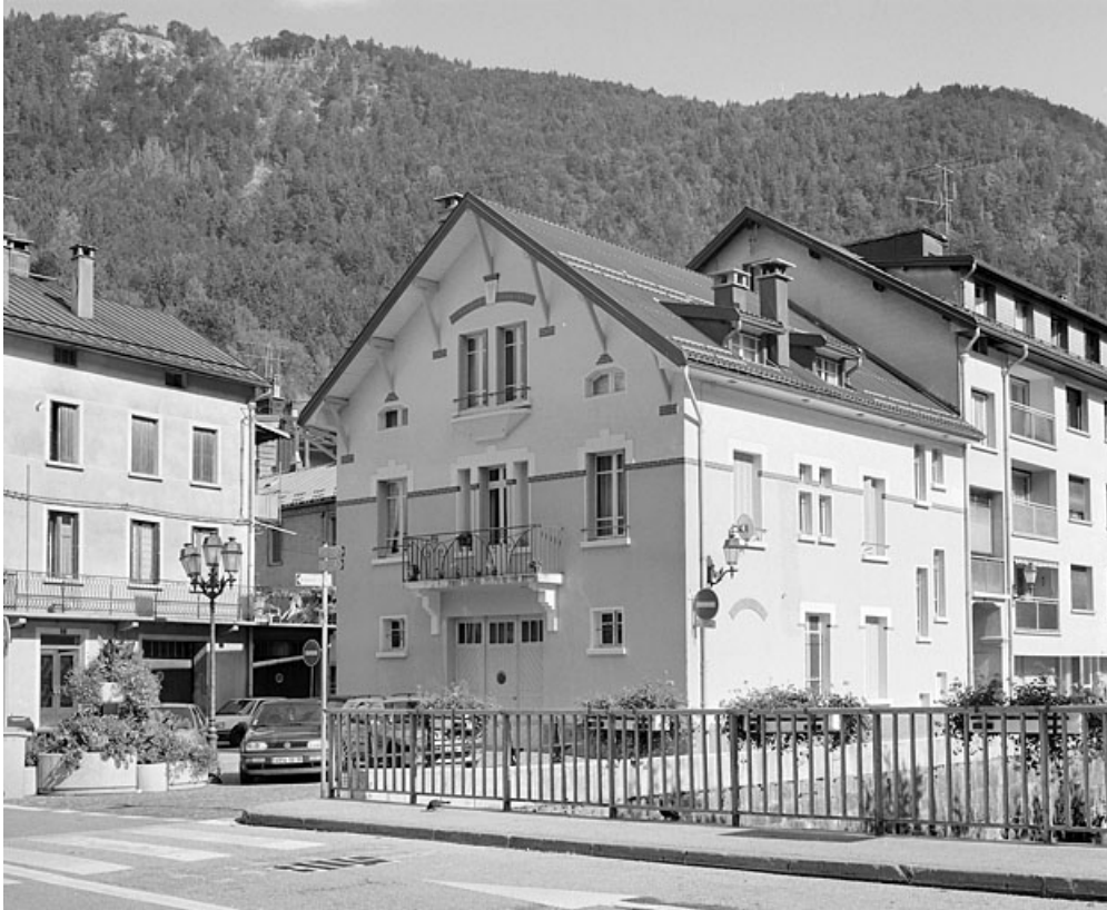
Façades antérieure et latérale droite.
