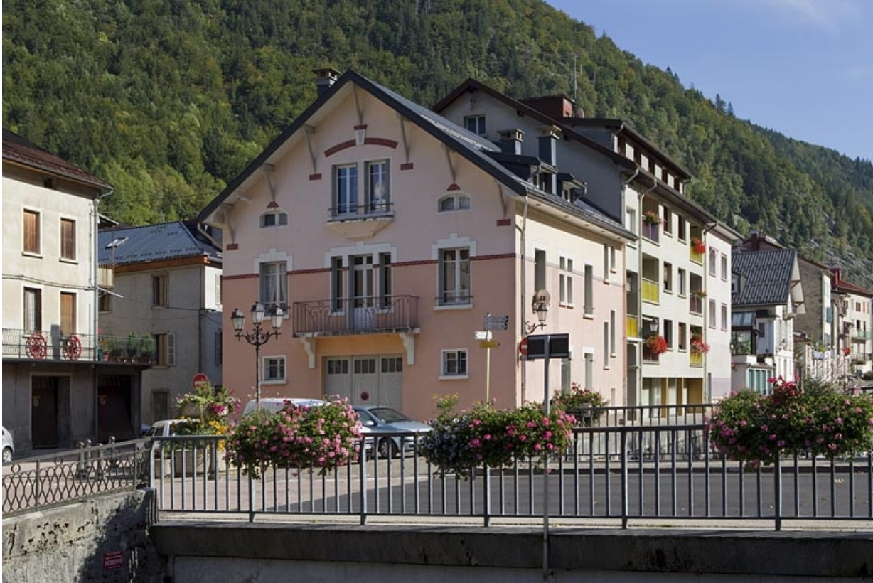
Vue d'ensemble, depuis l'ouest (cadrage horizontal).
