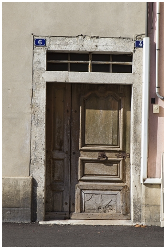
Porte principale sur la rue Merlin.
