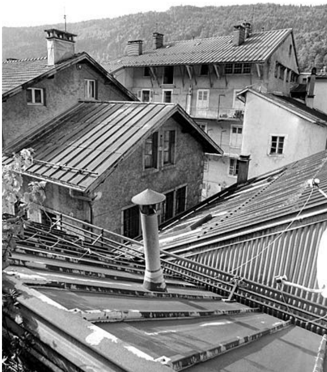
Toitures des bâtiments est et nord-est.
