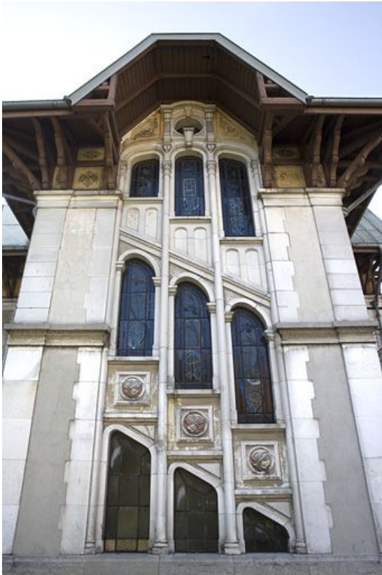
Elévation latérale gauche, en contre-plongée.
