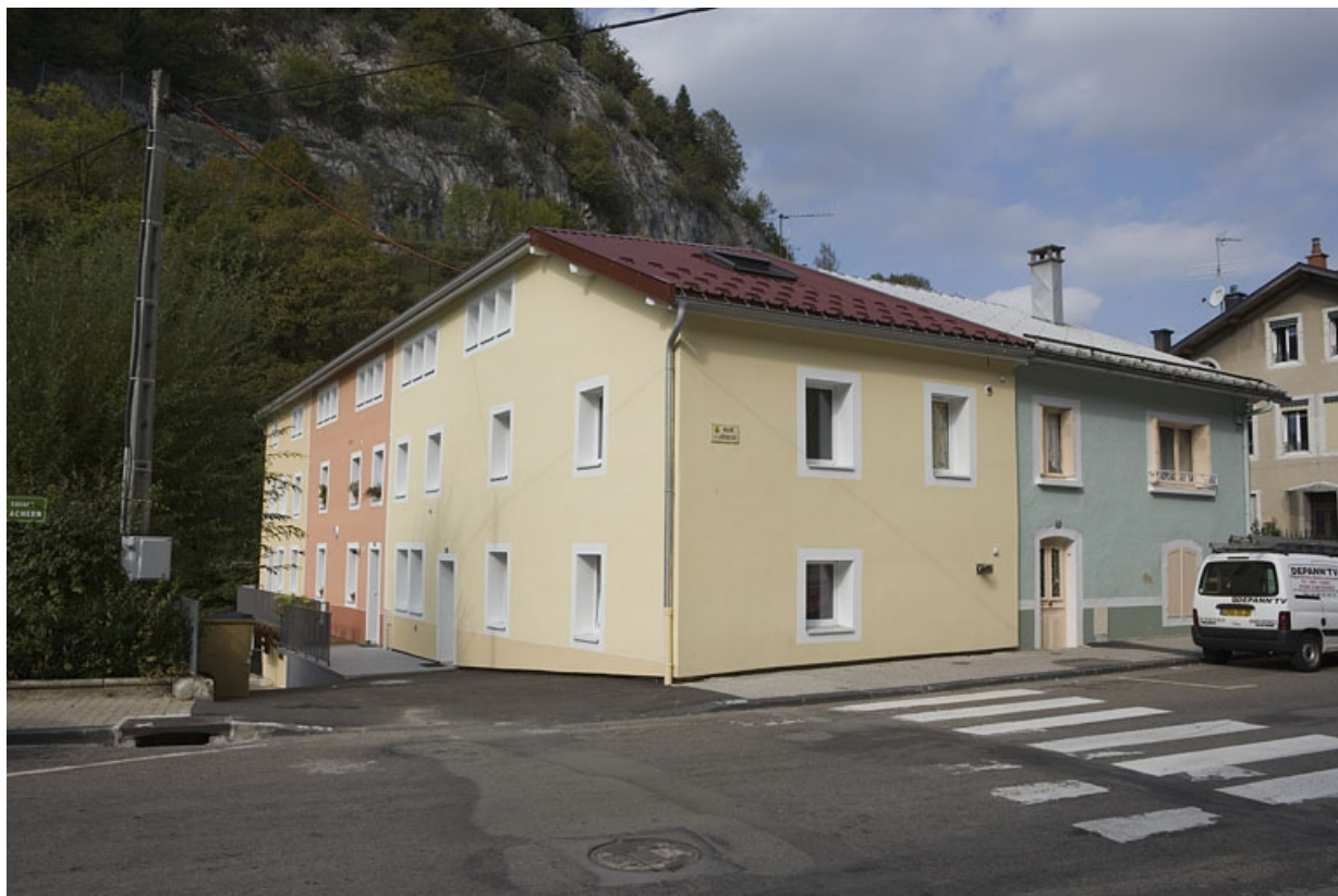
Vue de trois quarts, après restauration.
