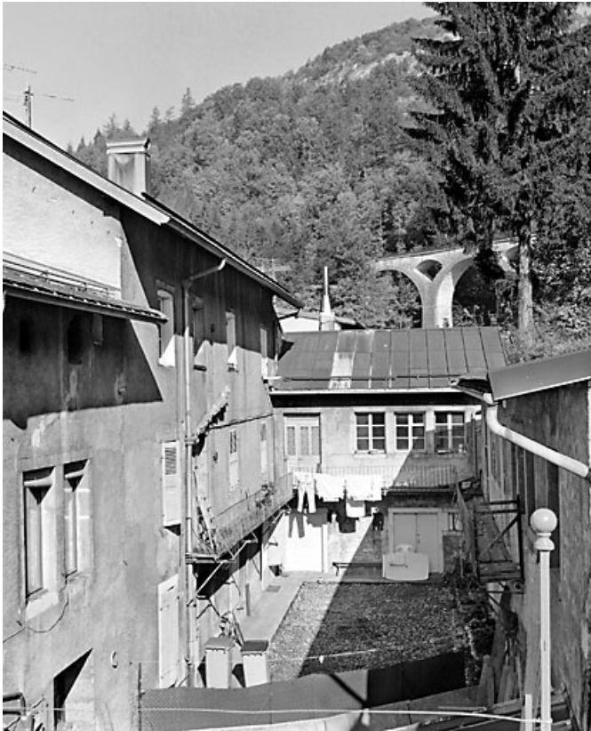
Façade postérieure, vue en enfilade.
