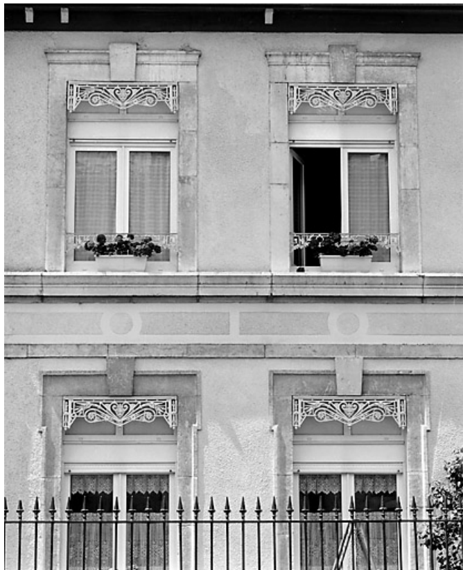
Élévation antérieure : baies.
