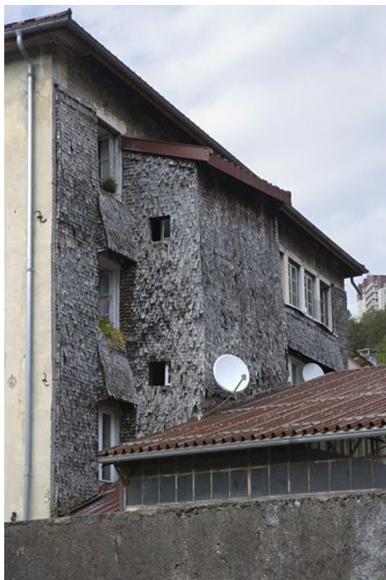
Façade latérale droite.
