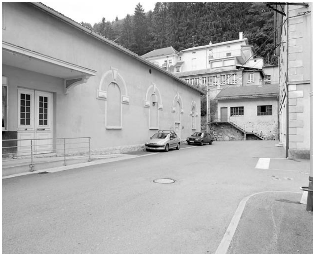
Élévation antérieure, de trois quarts gauche.
