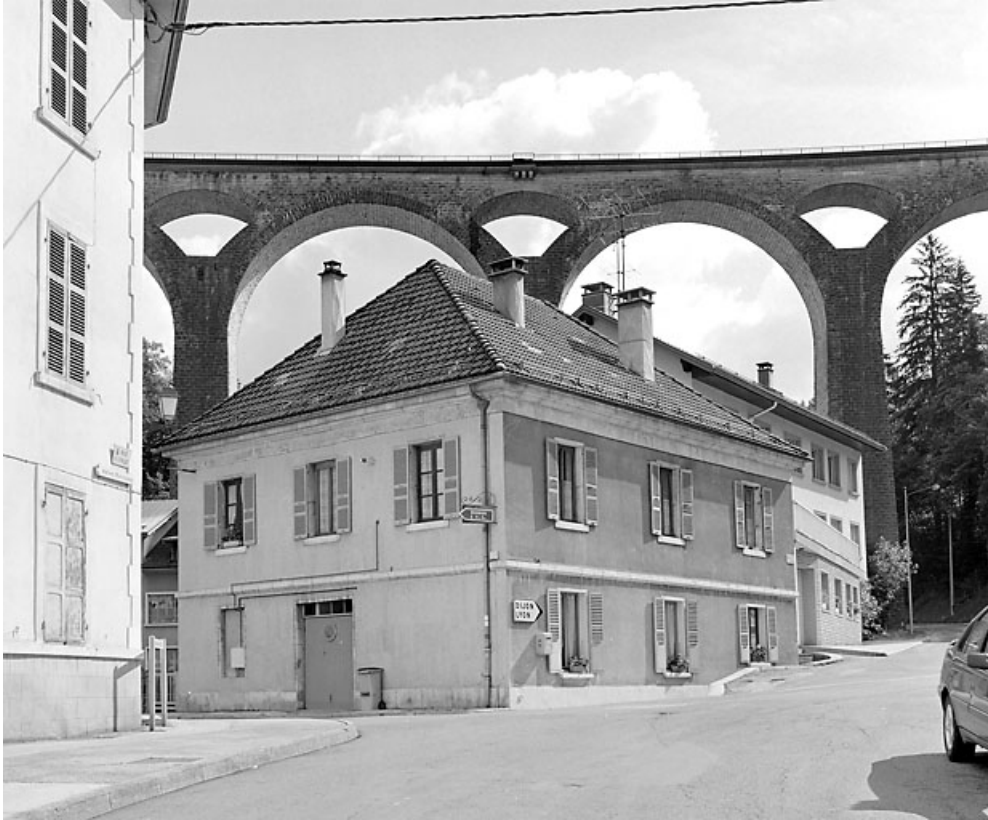
Façades antérieure et latérale gauche.
