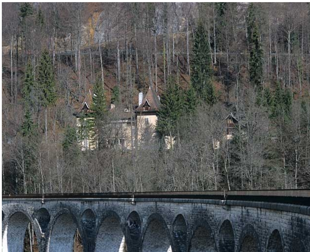
Vue d'ensemble rapprochée, depuis le sud-est.
