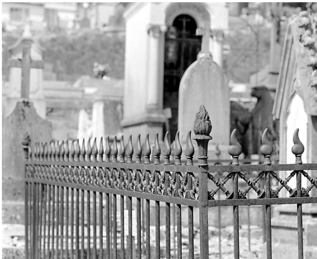
Détail de la grille de clôture.
