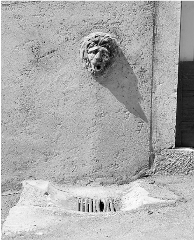
Bâtiment 3 rue Etienne Dolet : point d'eau.
