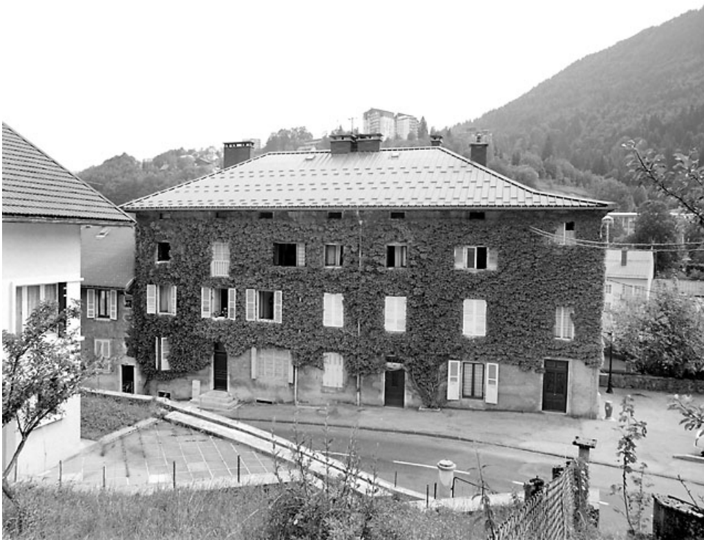
Bâtiment 11-15 rue Pasteur : façade antérieure.
