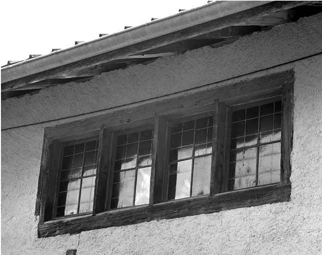
Fenêtres éclairant l'atelier ou "fenêtres de forge".
